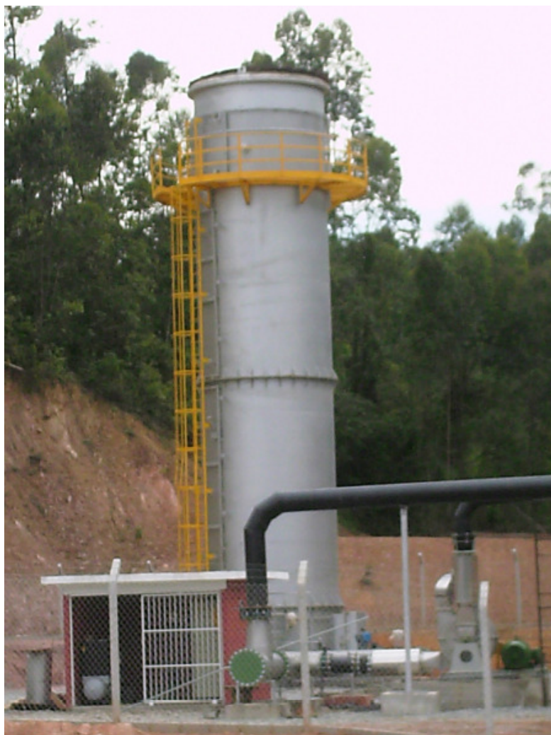
Figura 3.3 – Tubulação de sucção e flare [8].
